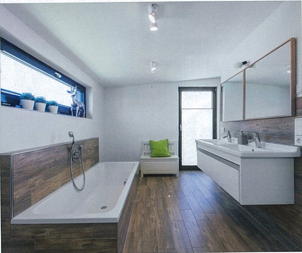
Die Vorliebe der Bauherren für Holz zeigt sich auch im Bad. Da dieses Material den ständigen Wasserkontakt im Nassbereich nicht verträgt, wählten sie für die entsprechenden Zonen keramische Fliesen mit einem Holzdekor .
